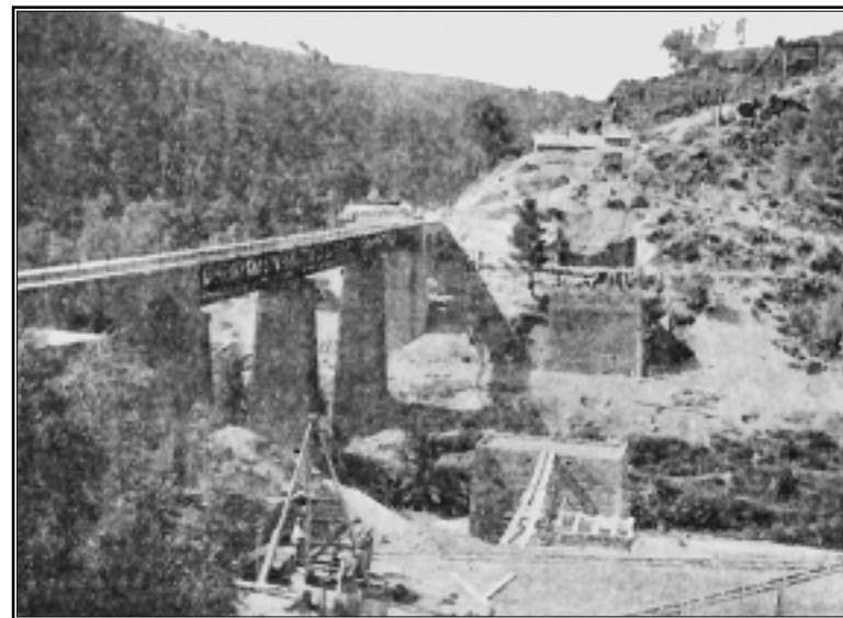
Construction d'un viaduc sur la ligne l'Ouenza.
