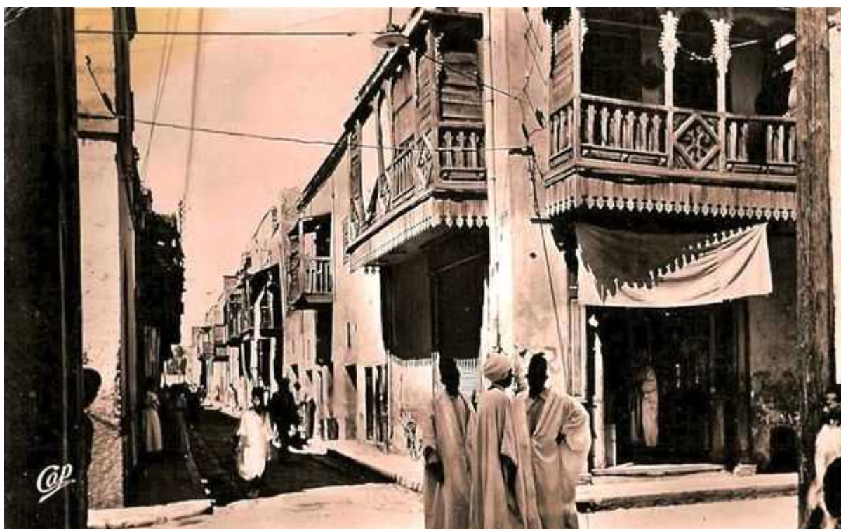
BISKRA : Les balcons de la rue Arcelin
